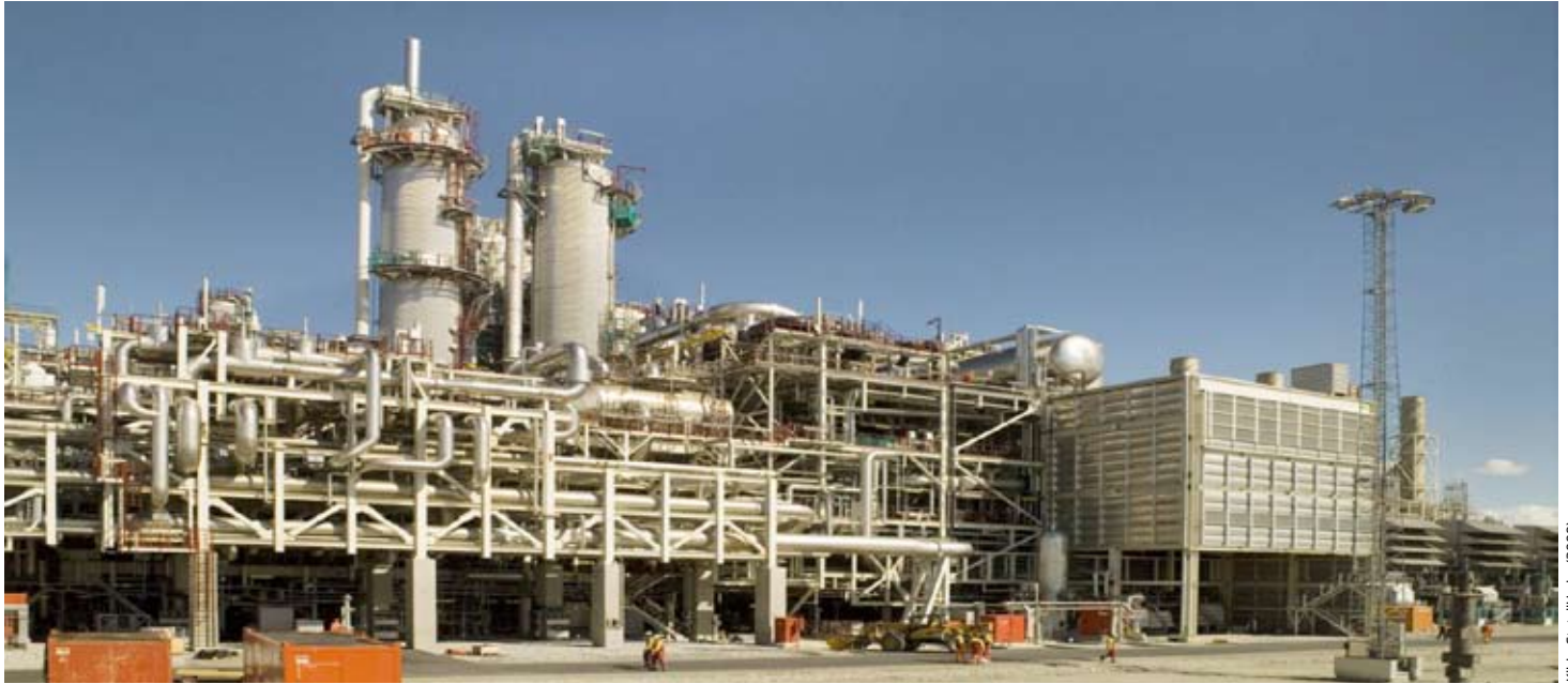
Figur 4: Fangstanlegg for CO 2 på Melkøya. De to store tårnene er hhv absorpsjonstårnet (høyre) og strippetårnet (venstre). Omfatter for øvrig anlegg for tørking av CO 2 -gassen for å hindre korrosjon og hydratdannelse, samt kompressor og pumpe som trykker gassen inn i returledningen til feltet hvor CO 2 injiseres.
