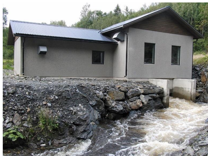
Figur 1 Grønningselva kraftverk i Levanger kommune er et typisk småkraftverk med installert effekt rett under 1 MW. Kraftverket har en forventet årsproduksjon på 2.8 GWh.
