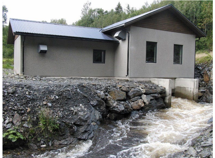
Figur 1 Grønningselva kraftverk i Levanger kommune er et typisk småkraftverk med installert effekt rett under 1 MW. Kraftverket har en forventet årsproduksjon på 2.8 GWh.
